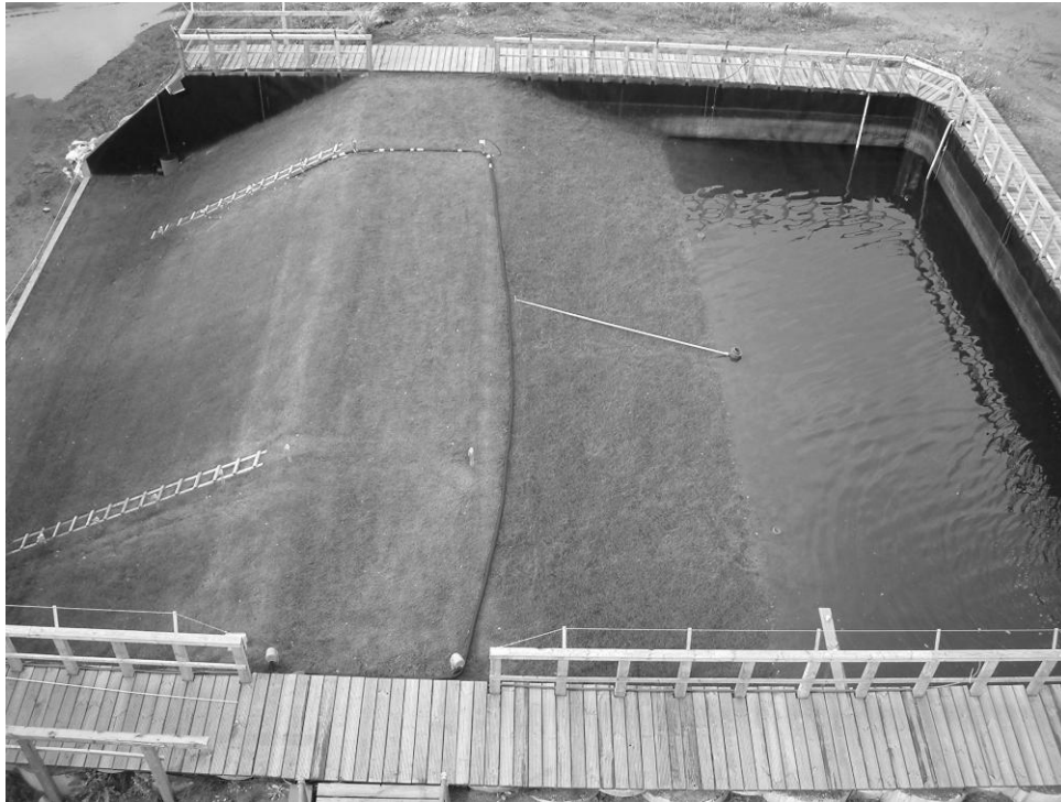
Abb. 3: Fertiger Labordeich (Füllstand ca. 1,5 m)
