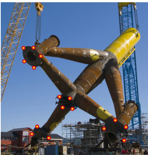
Abb. 1: Messpunkte der Echolote am Tripod [Stiftung Offshore Windenergie/alpha ventus, 2008]
