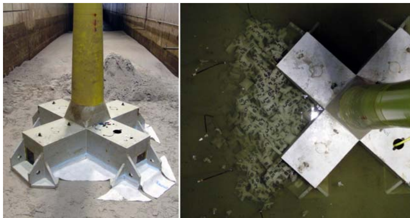
Abbildung 4: Fundament mit angebautem Vlies (links) und Fundament während der Einbauphase des Kolk­schutz­systems (rechts)
